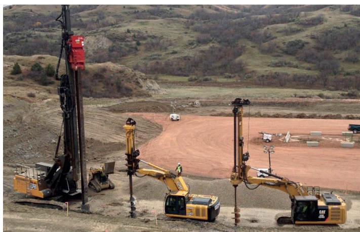
Figura 6. Columnas sistema Geopier - X1.
