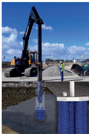
Figura 5. Columnas sistema Geopier - GP3 (Nuevo Seseña, Toledo)
